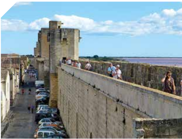
Ringmuren i Aigues-Mortes har sett i stort sett likadan ut i 800 år. Det går att vandra på den runt hela staden, en sträcka på drygt 1,5 kilometer.
