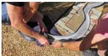
▲ Vid skarpa böjar limmar man med lite cyanolitlim.
